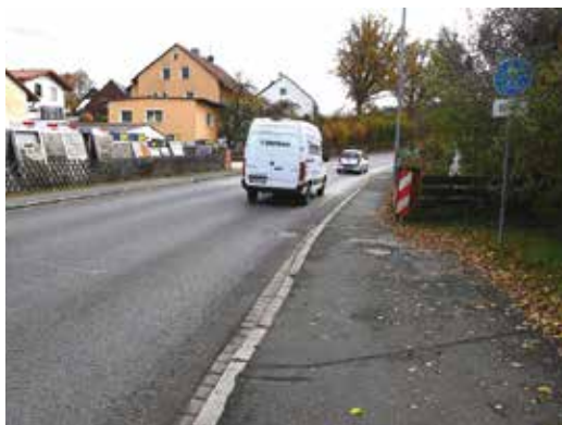
Typisches Beispiel für Radverkehrsprobleme im Landkreis Roth: Abruptes Ende eines Radweges auf der Kreisstraße RH1 in Wendelstein-Großschwarzenlohe. Trotz mehrfacher Hinweise zeichnet sich keine Verbesserung ab. (Foto: Klaus Tscharnke)
